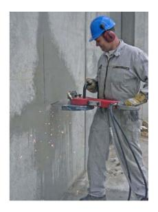
Отрезная пила HCS14 может использоваться как для горизонтальной, так и для вертикальной резки. Отрезная пила разработана для резки всех марок бетона, армированного бетона, стали, кирпича, асфальта и т.д.
